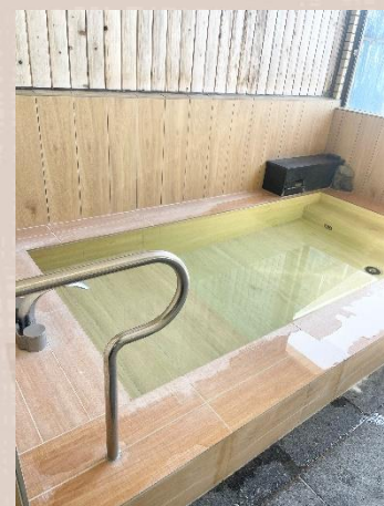
浴場到手摺り設置
