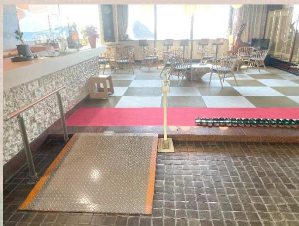
入口～ロビーの段差解消（スロープ）
